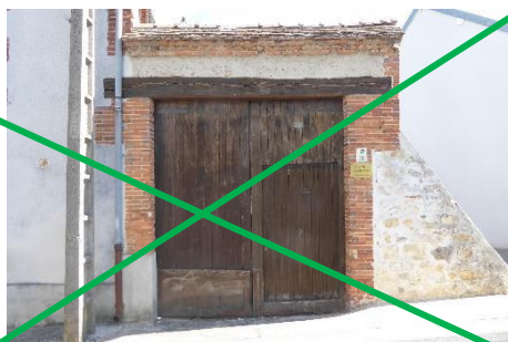
38 rue Pasteur (porche tombé lors de la réfection totale de la Rue Pasteur)
