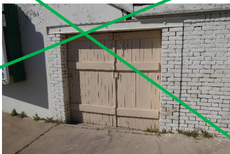
2 rue Jean Jaurès poutre IPN
